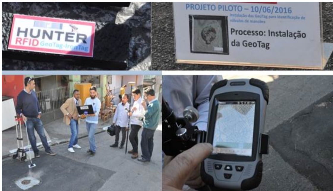
Figura 3: Identificação, Tagueamento e Georreferenciamento da Válvula na Rua Baquio Preto.
